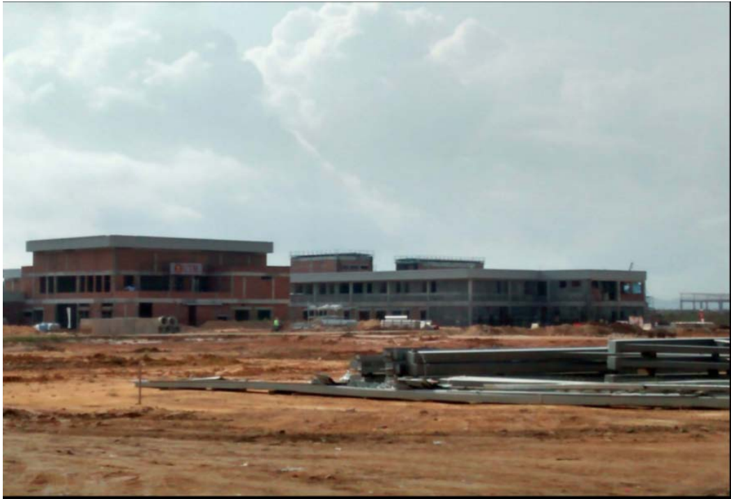
ジョホール・パゴ地区大学建設現場
