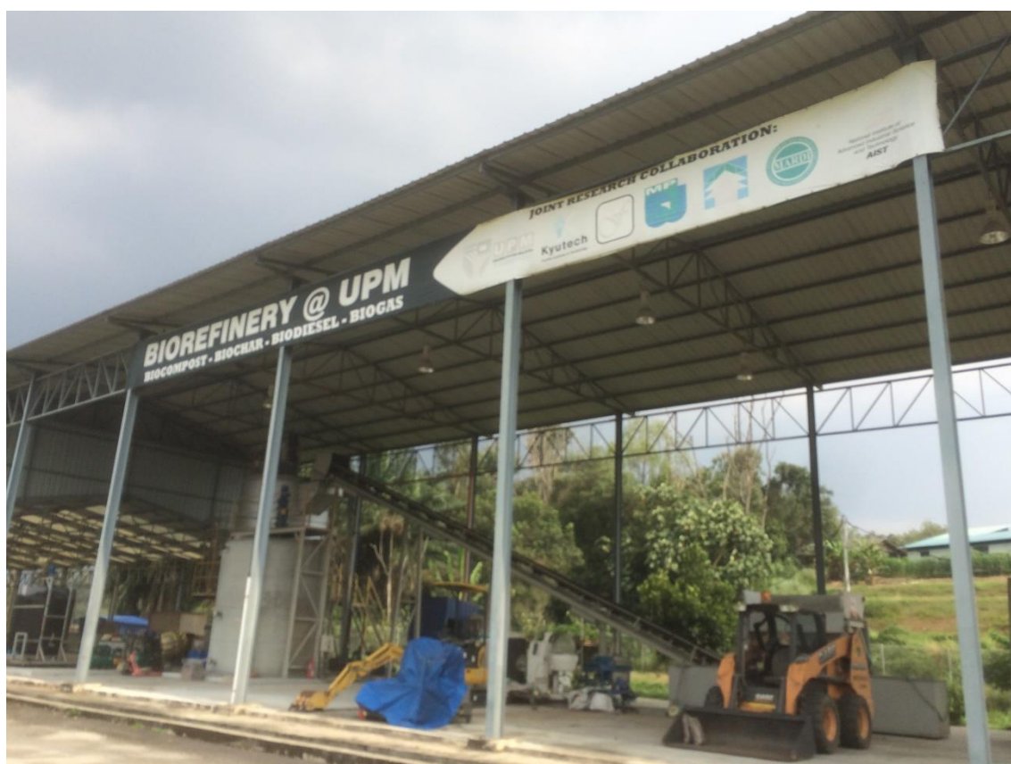
写真 4. アブラヤシの残渣からバイオガスを作るためのプラント
